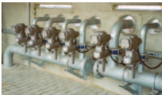
Неполнооборотные приводы AUMA с блоком управления AUMA MATIC на нефтебазе в Польше.
