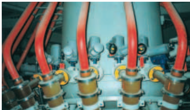
Неполнооборотные приводы AUMA на сероочистой установке электростанции.
