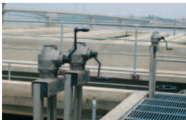
Конический редуктор для арматуры с ручным управлением на установке для очистки сточных вод во Вьетнаме.
